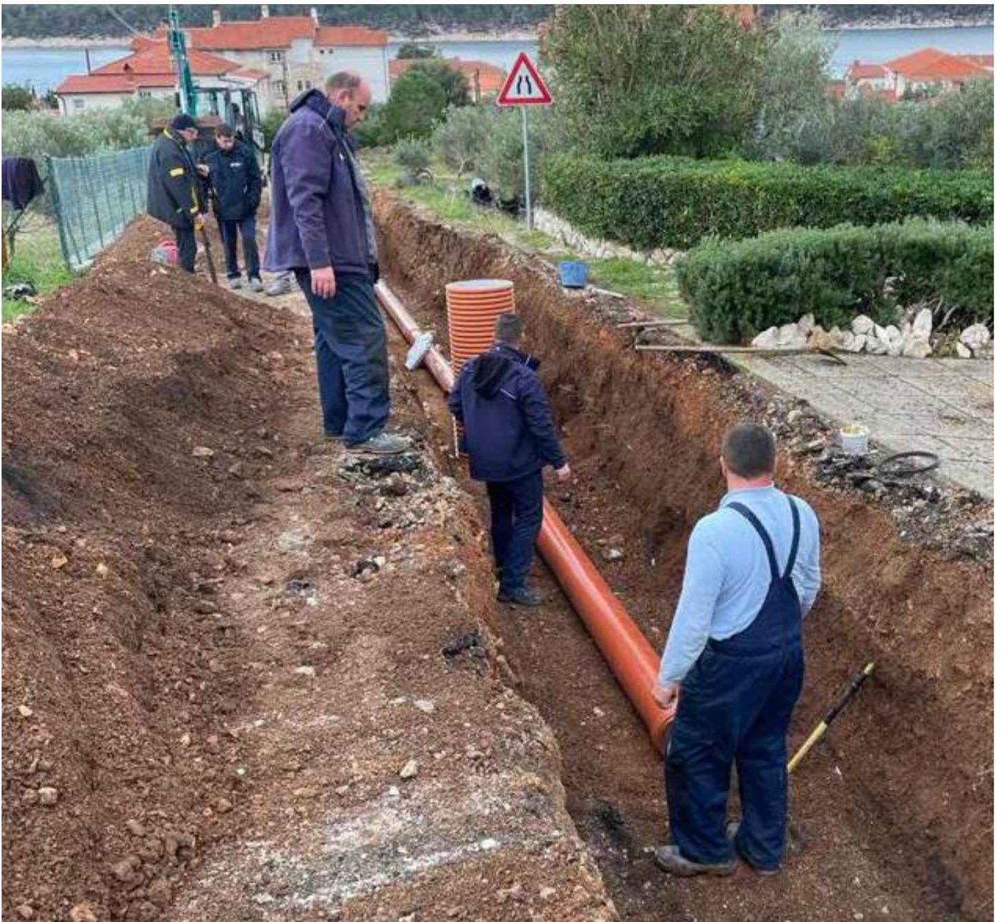
Priključno okno je mjesto u kojem je moguće vršiti kontrolu funkcionalnosti kanalizacijskog priključka, mjeriti protok i uzimati uzorke za kontrolu kvalitete otpadnih voda.
