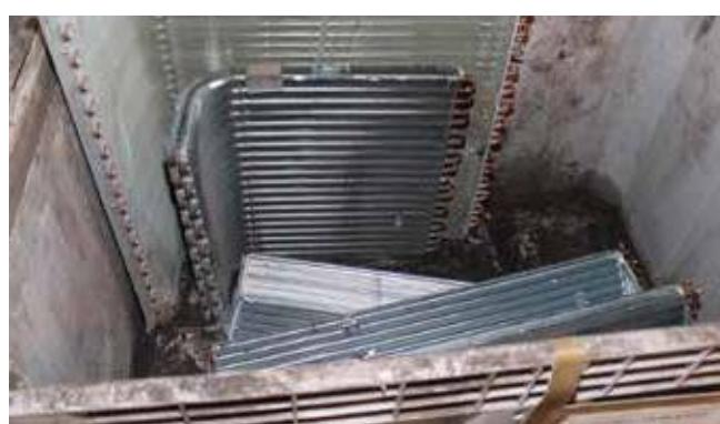
Na slici su prikazani bakreni i aluminijski dijelovi iz rashladnih uređaja koji se koriste kao sekundarna sirovina u tzv. rafinerijama obojenih metala. Upravo su ovi dijelovi razlog zbog kojeg neovlašteni i ilegalni sakupljači uzimaju otpadnu tehniku (hladnjake i klima uređaje). Rastavljanjem ovih uređaja bez adekvatnog alata dolazi do nekontroliranog ispuštanja freona u atmosferu.
