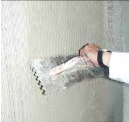
Ulaganje staklene mrežice u svježi sloj ljepila
