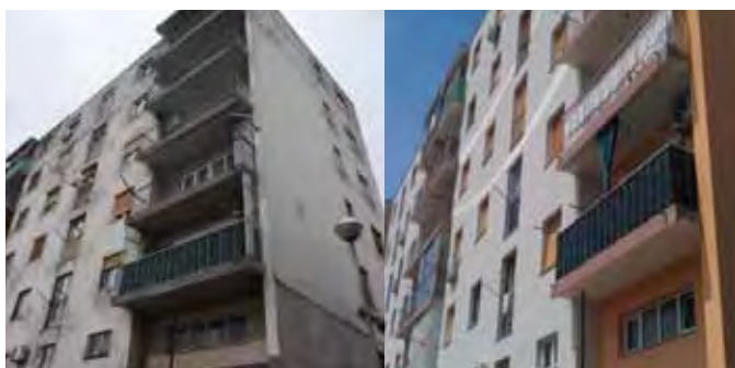
Prije i poslije sanacije
