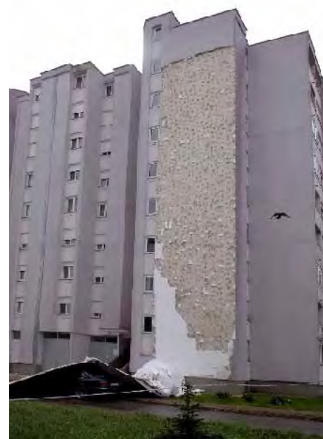
U Vukovaru pala fasada sa zgrade
