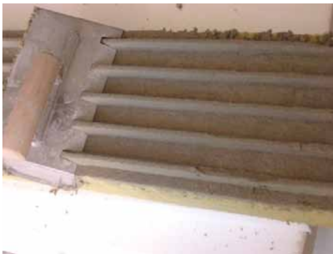
Nanošenje ljepila na lamele od mineralne vune
