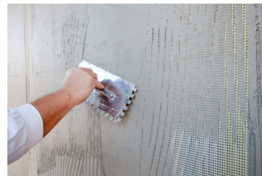
Slika 3. Nanošenje armaturnog sloja na toplinski izolator
