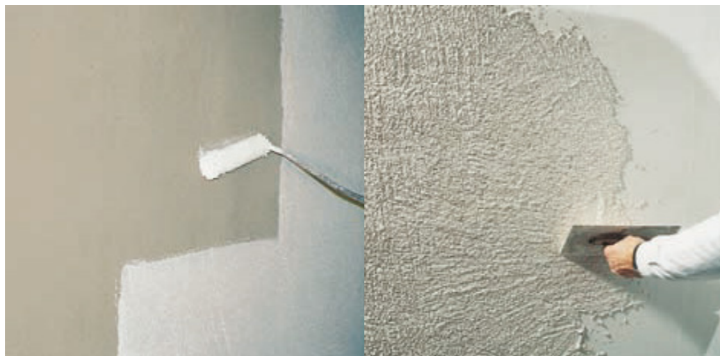
Slika 4. Nanošenje predpremaza (lijevo) i završno-dekorativne žbuke
