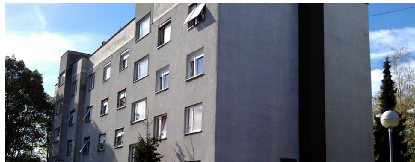
Stambena zgrada Ruđera Boškovića 2, Varaždin, ugrađena oprema: kondenzacijski kombinirani uređaj Condens 3000 W, ZWB 24-3, 54 kom
